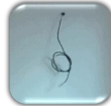
Kabel über Waschbecken
